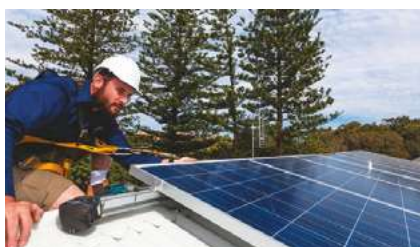
СОНЯЧНА ЕЛЕКТРОСТАНЦІЯ ООО «МИИА ГРУП» Дніпро 2019
