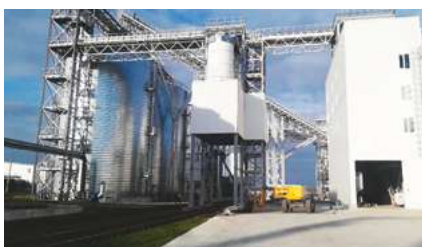
РЕКОНСТРУКЦІЯ: СУШИЛЬНИЙ ЦЕХ ТОВ «УХЛК» Житомирська обл., 2018
